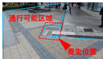
③通路狭小箇所
