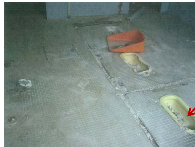
施工中(撤去完了 タイル撤去の例)
