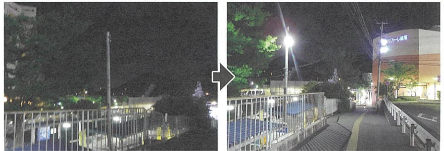
新たに街灯を設置(地下鉄 妙法寺駅周辺)
