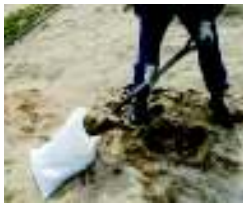
スコップで土のうに土を入れ、口を紐で絞る
