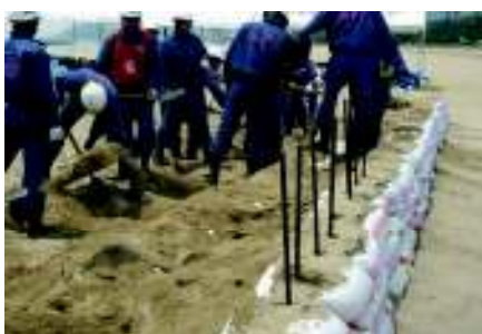
積土のう工法
