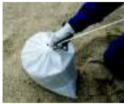
スコップで土のうに土を入れ、口を紐で絞る
