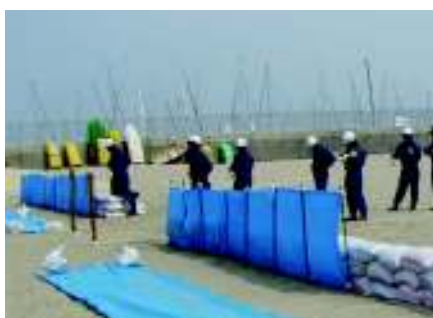
改良積土のう工法
