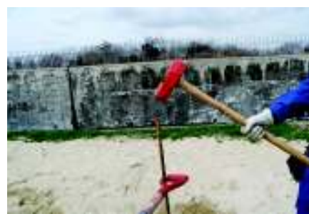
鉄杭の打ち方
