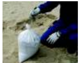
指に紐を通して2,3回まわし、指の穴を通して縛る
