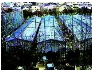
建設が進む仮設住宅
