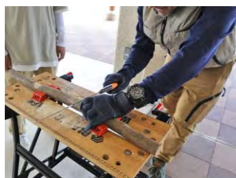
斜めに切れ込みを入れる作業に苦戦
