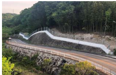
<道路防災対策>
