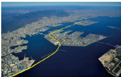
<大阪湾岸道路>
