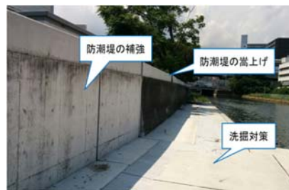
<防潮堤の補強>
