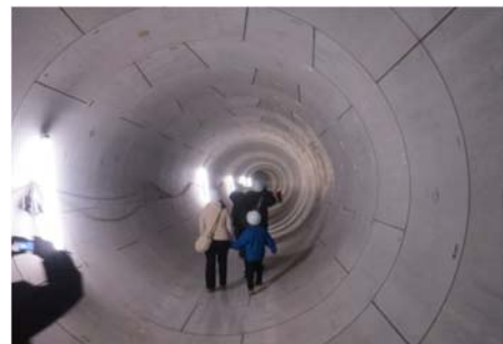
<ポンプ場・放流渠の整備>
