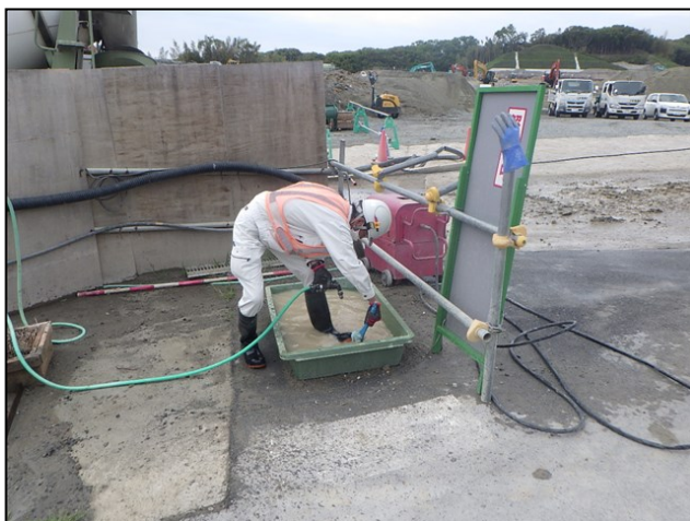
図 3-13 泥落としマットの設置
