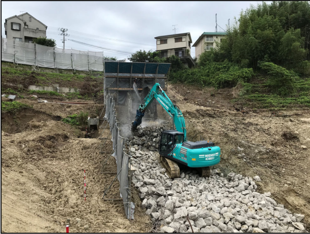
図 3-35 防音シートの設置
