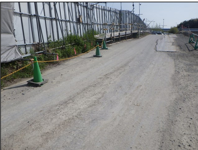
図 3-19 工事用道路舗装
