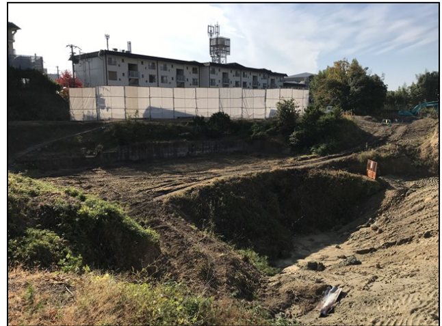
図 3-18 防塵ネットの設置（2）
