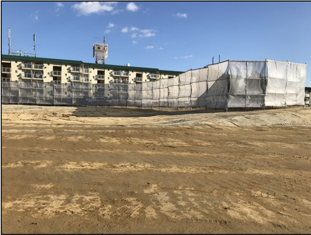
図 3-17 防塵ネットの設置（1）
