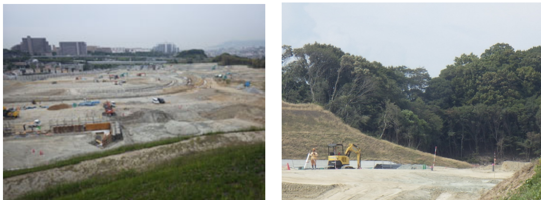
図 3-43 事前調査時に確認した対象地区の状況
