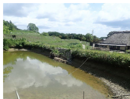
白拍子下池 堤体補修工事箇所
