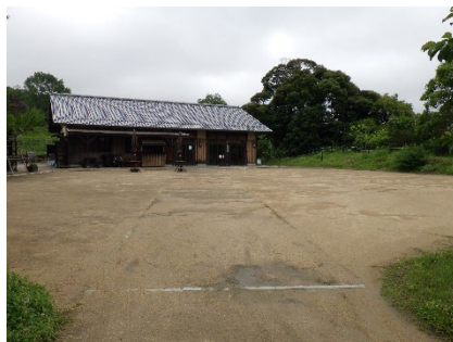
白拍子のにわ 舗装補修工事箇所
