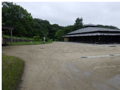
里山交流館 舗装補修工事箇所
