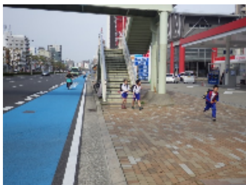
車道上の自転車レーン（兵庫区 国道 28 号）
