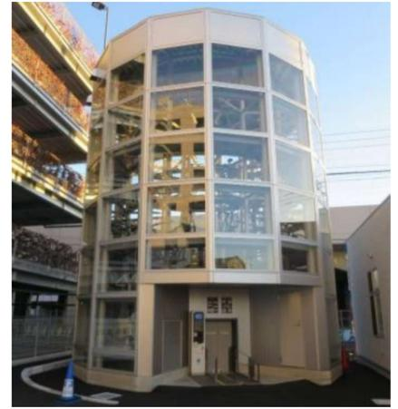
写真. 駐輪部分が地上に設置されたタワー式駐輪場出入口
