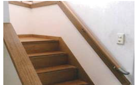
【「バリアフリー住宅改修補助事業」での事例】
