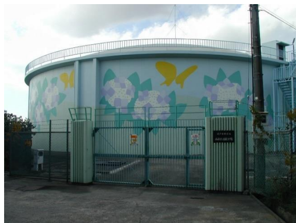
西神低層配水池
