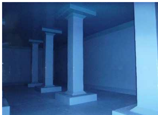
配水池の内面
