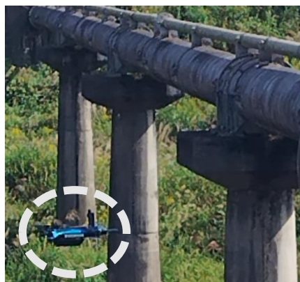
ドローンによる点検
