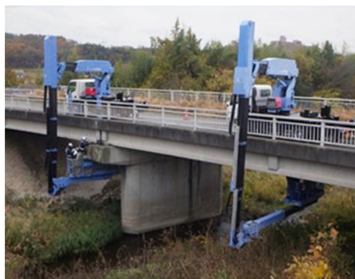
橋梁点検車による点検
