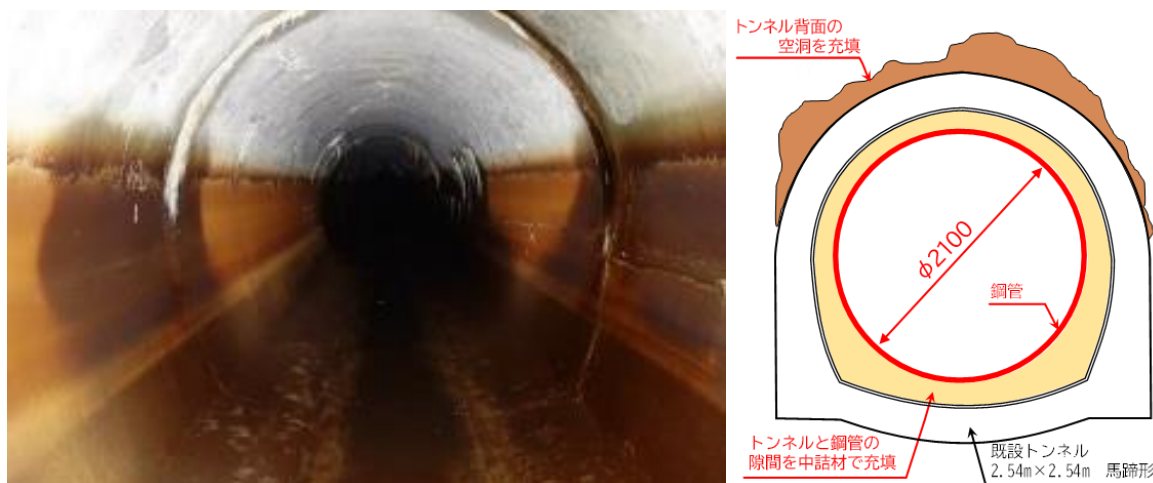
4 拡送水トンネル
