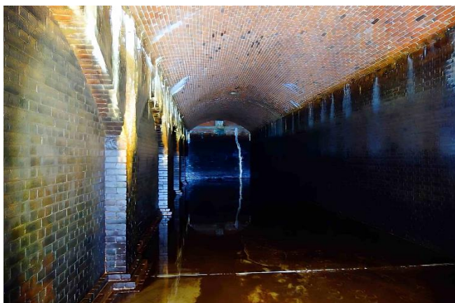
奥平野低層配水池
