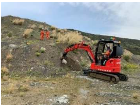
重機を活用した訓練
