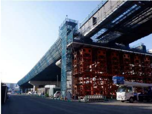
大阪湾岸道路西伸部 整備状況 (東灘区 向洋町)
