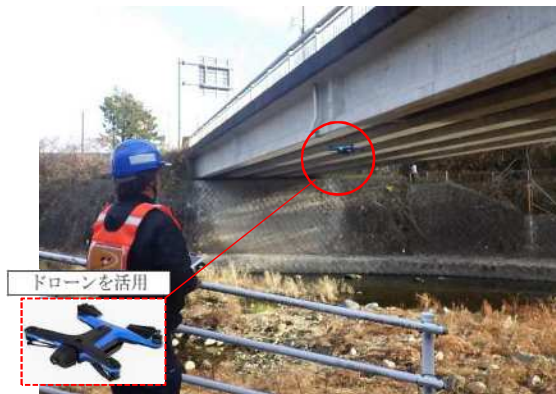
橋梁点検 (北区 新坂本橋)
