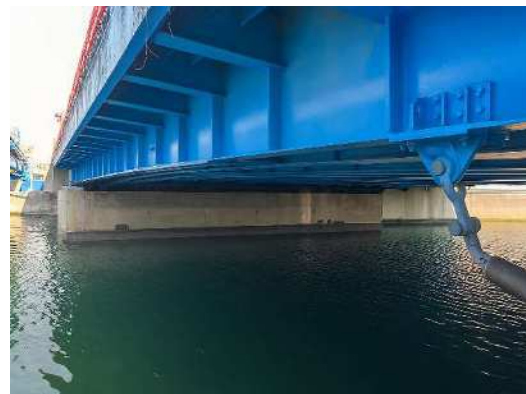
橋梁補修 (兵庫区 高松橋)
