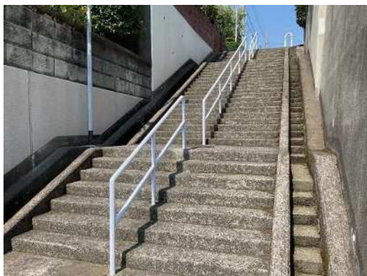
手すりの新設 (垂水区 つつじが丘)
