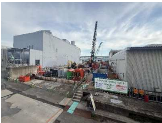
魚崎ポンプ場改築更新事業（第2期） （東灘区 魚崎南町）
