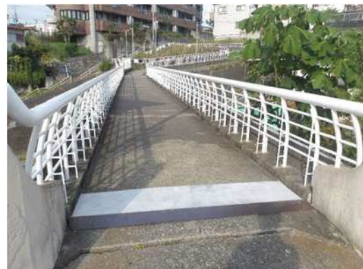
手すりの整備後
