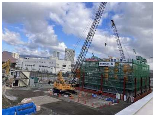
ポートアイランド処理場改築 (中央区 港島中町)
