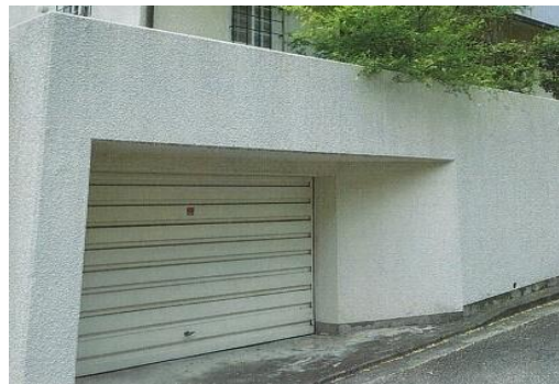
地盤面を構成している掘り込み車庫(残置する場合は、車庫の内部全体が分かる写真も必要)
