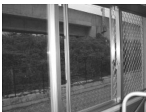
窓が全開できないように安全面の工夫をしている
