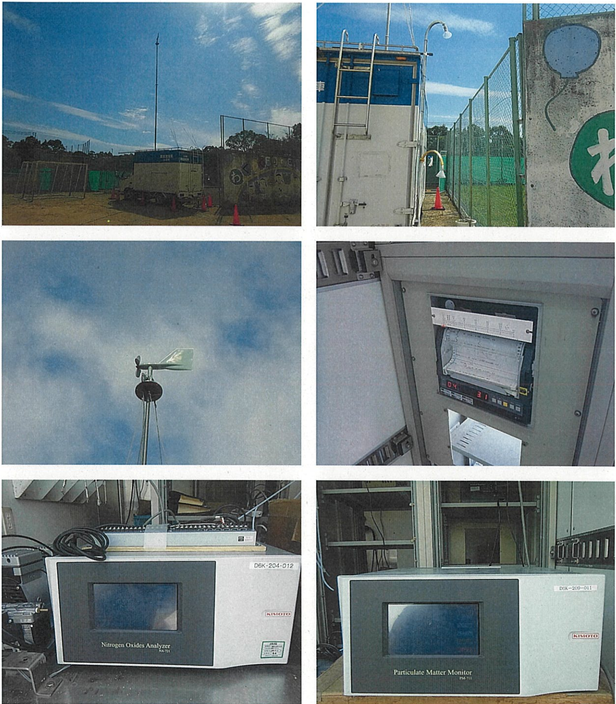
図 3-1-5 調査地点の状況
