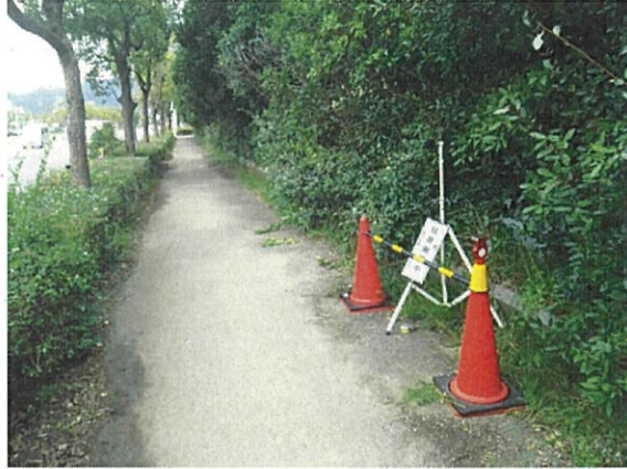
西側臨港道路_東側道路端
