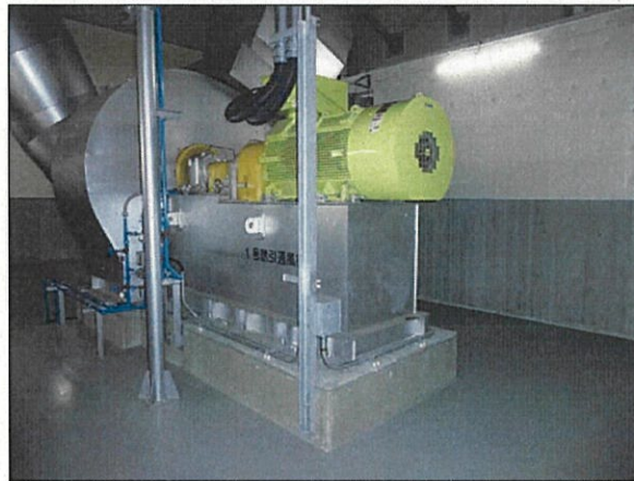
図 3-3-3 コンクリートの基礎上に機器を設置（誘引通風機）
