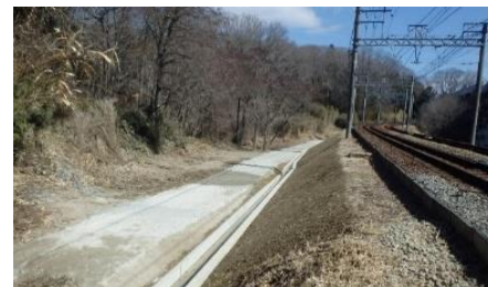
線路の法面保護
