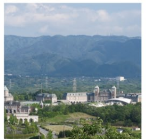
道の駅神戸フルーツフラワーパーク大沢
