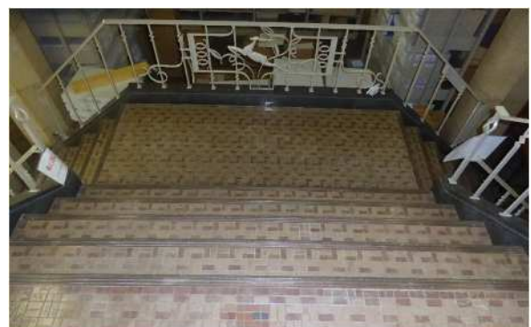
2～3階階段（3階南から）
