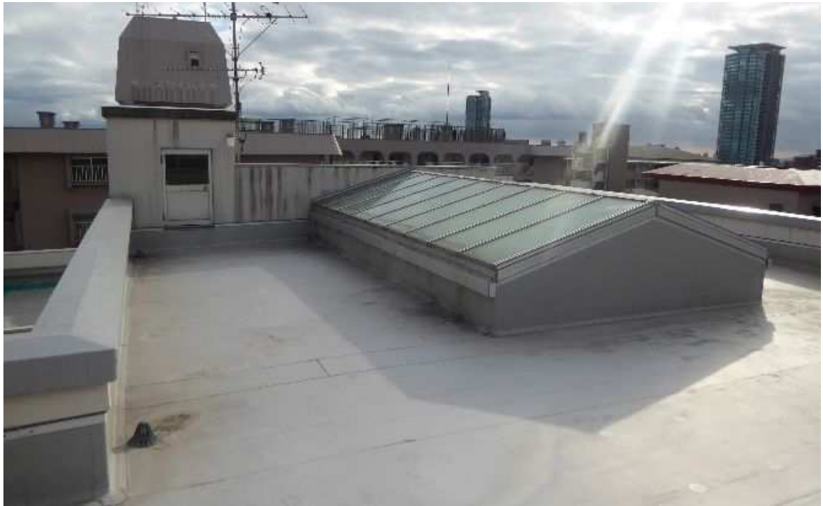
屋上（北東から）
