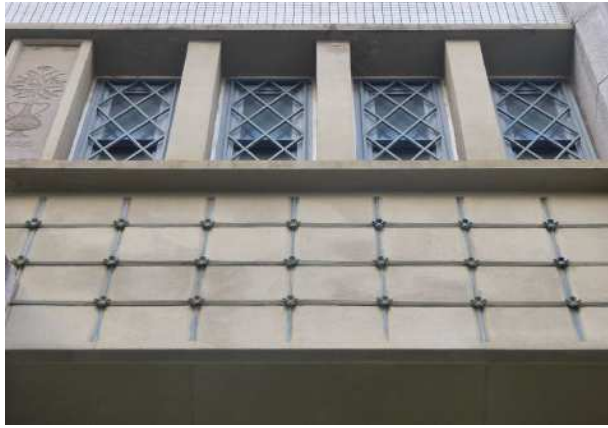
北面2階部壁面装飾・窓（北から）
