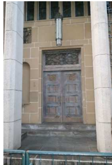
玄関部（北から）
