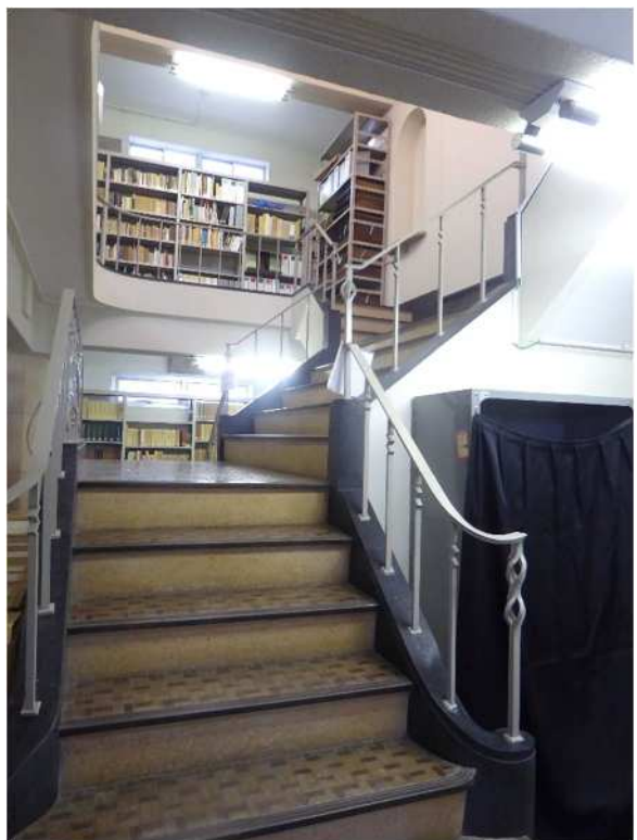
2～3階階段（西から）
