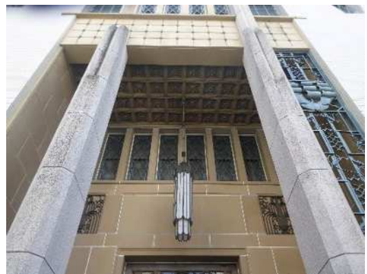
玄関上部（北から）
