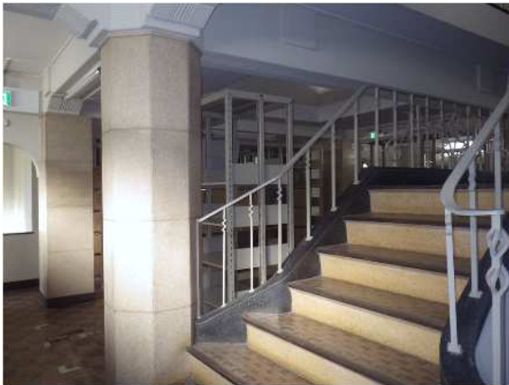
2～3階階段（西から）
