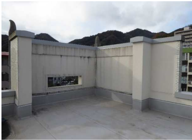
屋上旧塔屋（南東から）
