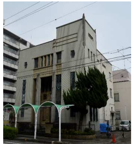
旧池長美術館全景（北西から）
