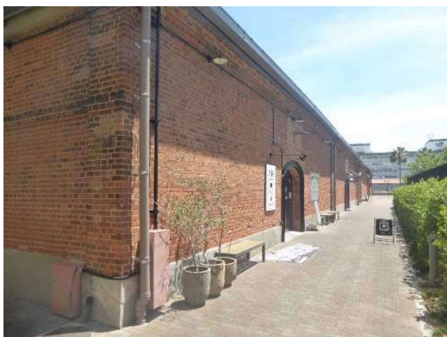
3. 北棟西面(北西から)
