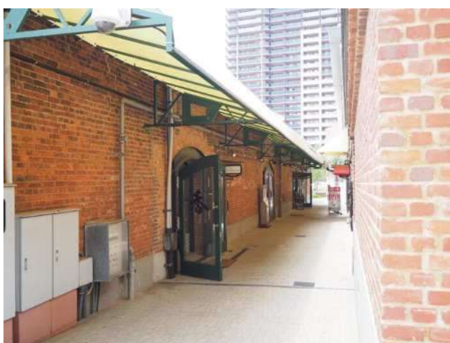
5. 2棟間の路地(東から)
