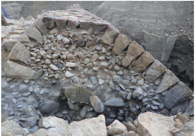
4 上層遺構 中央トレンチ 防波堤の断面（東から）
