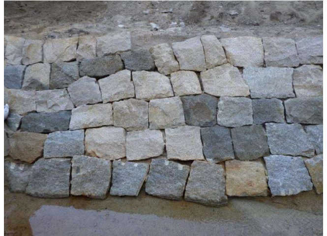
8 下層遺構 防波堤南面の石積構築状況（南から）
