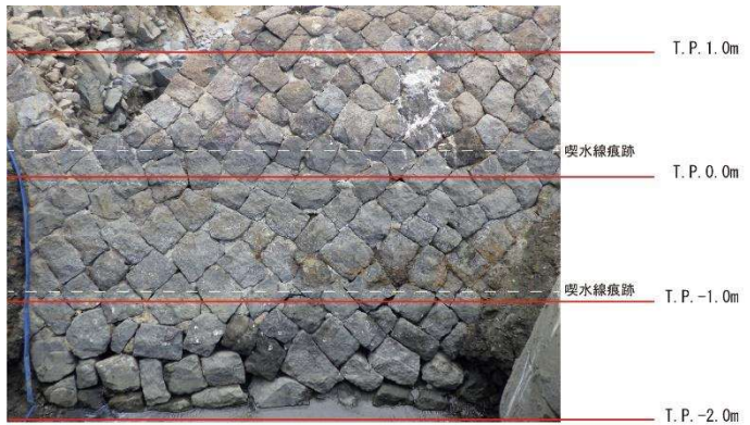
中央トレンチ北側防波堤
