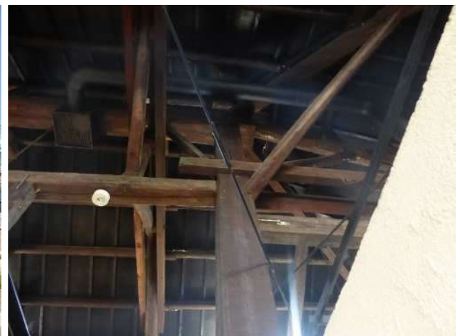
10. 南棟小屋組(部分)
