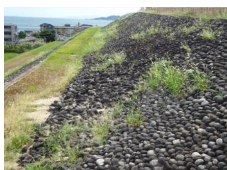
写真-10 前方部東側2段目 (S49年施工)
