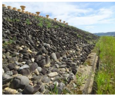
写真-2 前方部西側3段目 (S43年施工)
