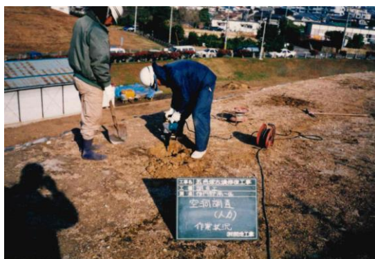
空洞調査実施状況
