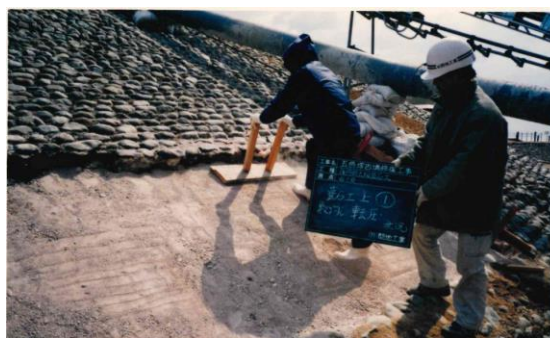
葺石目地層修復状況
