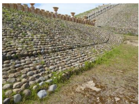
写真-9 前方部西側2段目 (S49年施工)
