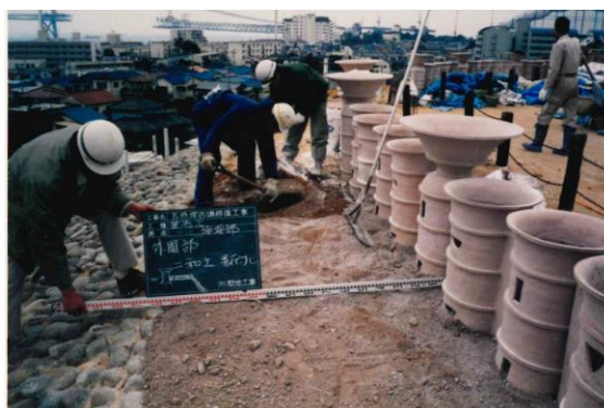
修復作業状況
