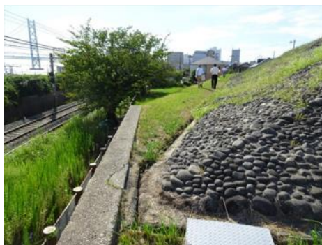
写真-3 前方部南側2段目 (S44年施工)
