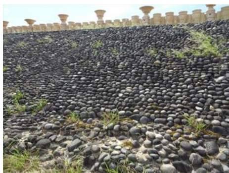
写真-5 前方部東側3段目 (S45年施工)
