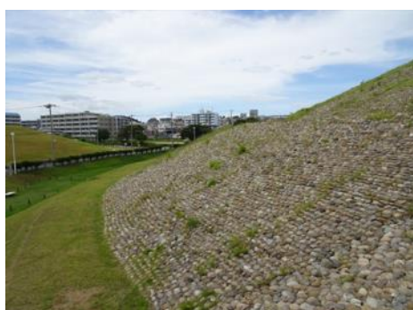
写真-8 後円部西側2段目 (S48年施工)
