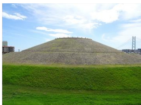
写真-7 後円部北側全景 (S48年施工)
