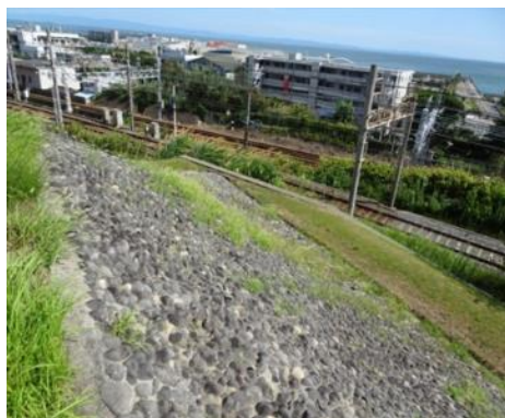
写真-1 前方部南側2段目 (S43年施工)
