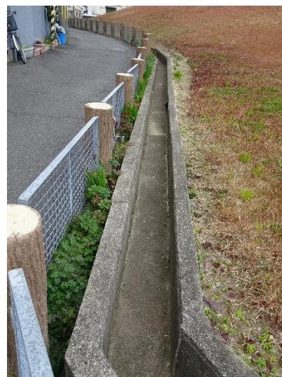
小壺古墳 側溝
