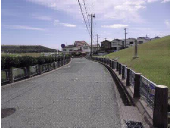
アスファルト舗装
