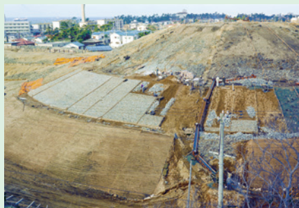
後円部の復元工事
