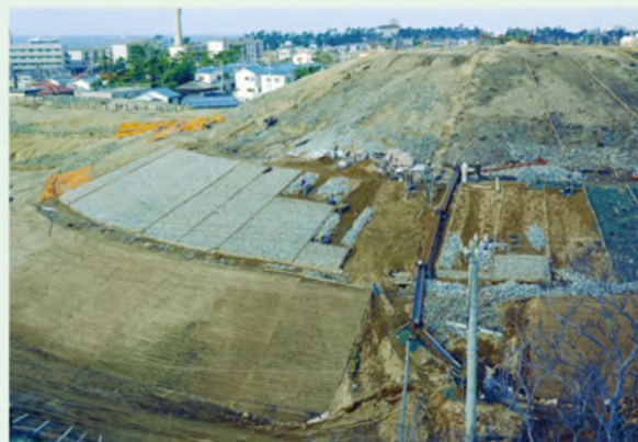
後円部の復元工事
