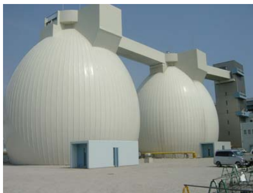
東灘処理場 消化タンク（消化ガスが発生）
