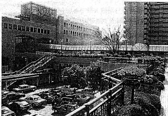
■ 歩行者デッキが駅舎・駅ビルと再開発ビルを結んでいる。
