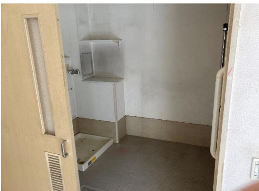
□浴室 浴室高さ：480mm 入口 アコーディオンカーテン有
