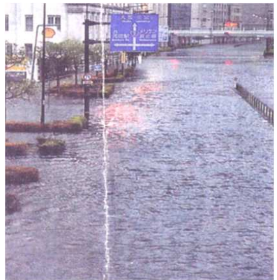
図 6-2-3 2 号線冠水の様子
