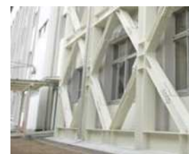
小学校の耐震改修例
