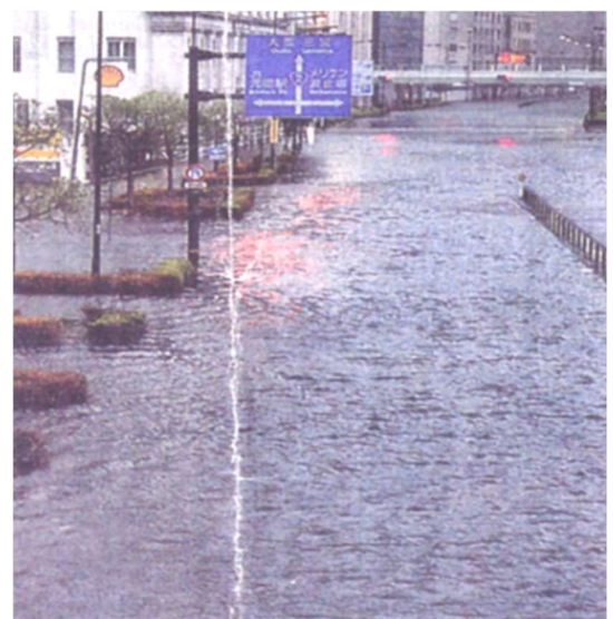
図 6-2-3 2 号線冠水の様子
