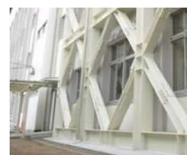
小学校の耐震改修例
