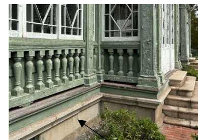
基礎モルタル
