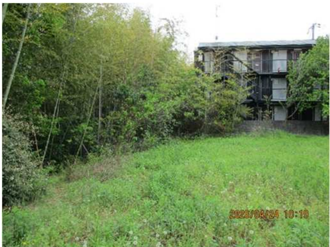
中央付近から南西方向
