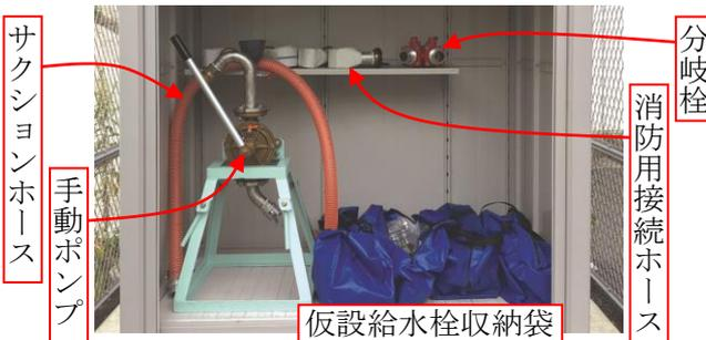
⑤手動ポンプに分岐栓を取り付け、各栓に消防用接続ホースで仮設給水栓を2セットずつ連結する。
