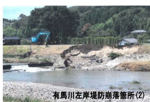
有馬川左岸堤防崩落箇所(1)
