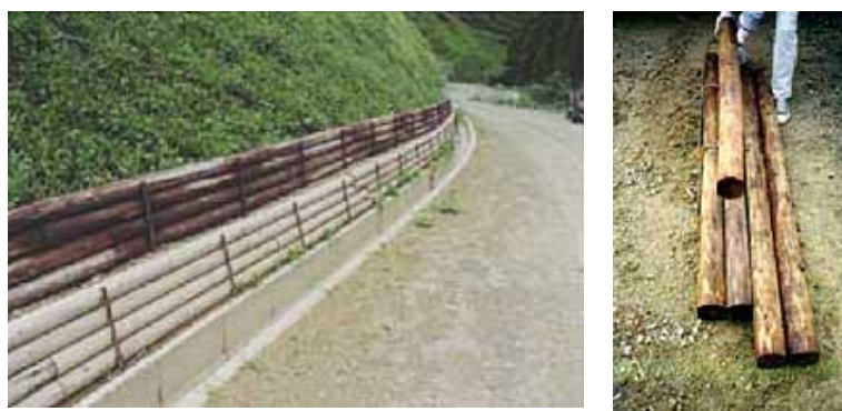
図 78 林道法面の土留めへの利用
