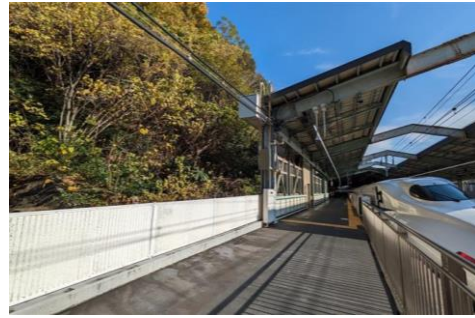
駅舎に近接した森林（新神戸駅）
