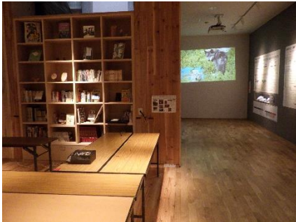
針葉樹・広葉樹の内装 (森林植物園展示館)
