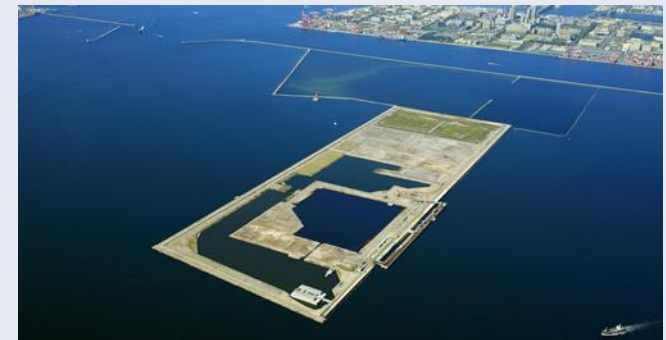
〔神戸沖埋立処分場〕
