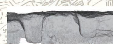
4. 第Ⅰ期 防波堤 石積み
