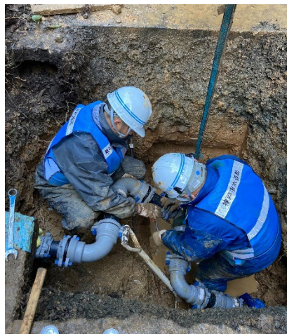
管路漏水修繕
