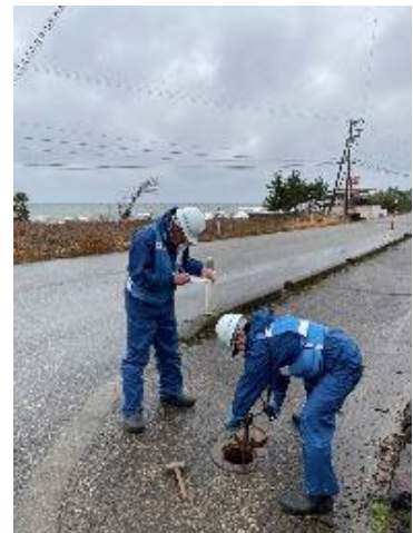
水栓作業（バルブ操作）
