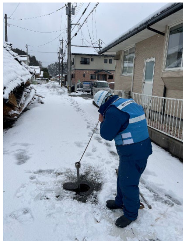
漏水調査状況
