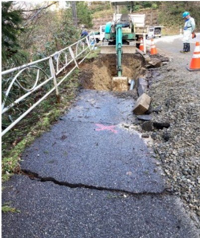
管路漏水修繕
