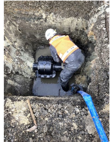
管路漏水修繕
