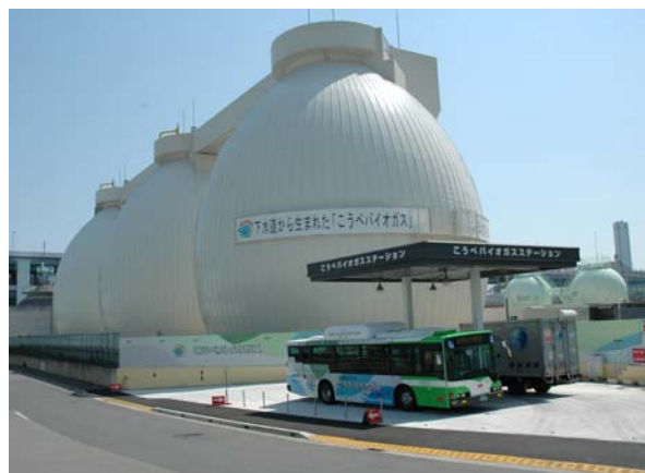
こうべバイオガスステーション（東灘処理場）
