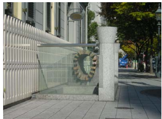
旧神戸外国人居留地煉瓦造下水道 （近代土木遺産）
