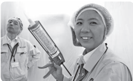
マーガリン工場の改装現場で従事する石野さん(右)
