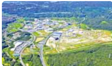
西区の産業団地(神戸テクノ・ロジスティックパーク)
