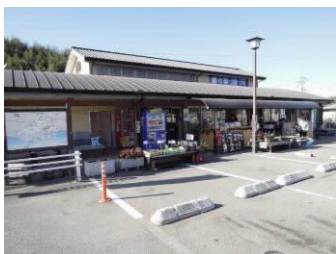
道の駅淡河の現況
