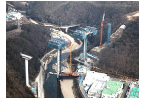
橋梁の施工状況 【新名神高速道路】 (平成26年5月現在)
