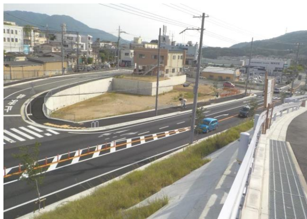
神 戸 三 田 線 ( 大 池 ) 等 ( 沿 道 整 備 街 路 事 業 )
