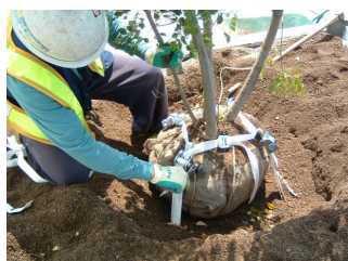
■地下支柱の例
